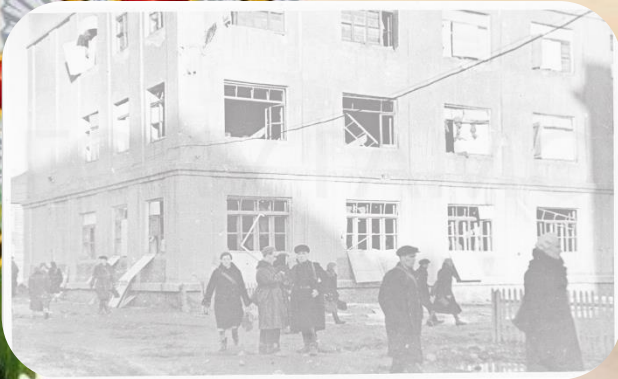
Здание школы № 10 после воздушного налета
