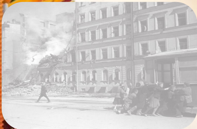
Разрушенные дома после бомбардировки, 1942 г.
