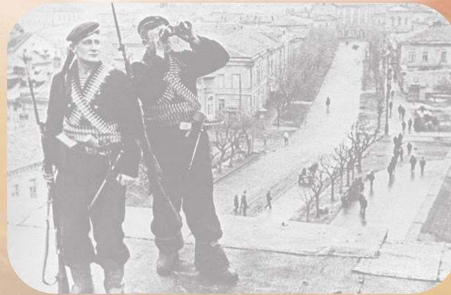
Краснофлотцы ведут наблюдение на крыше дома
