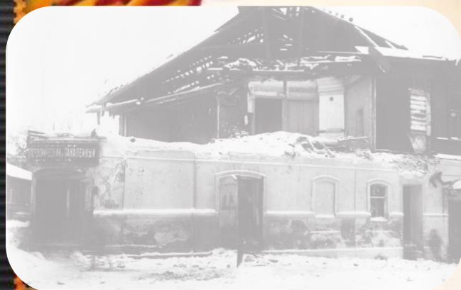
Разрушенный дом. Тула. 1941
